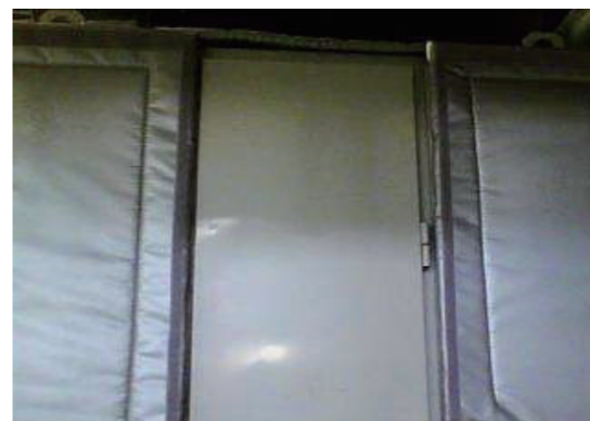
えこきーぱー施工前
